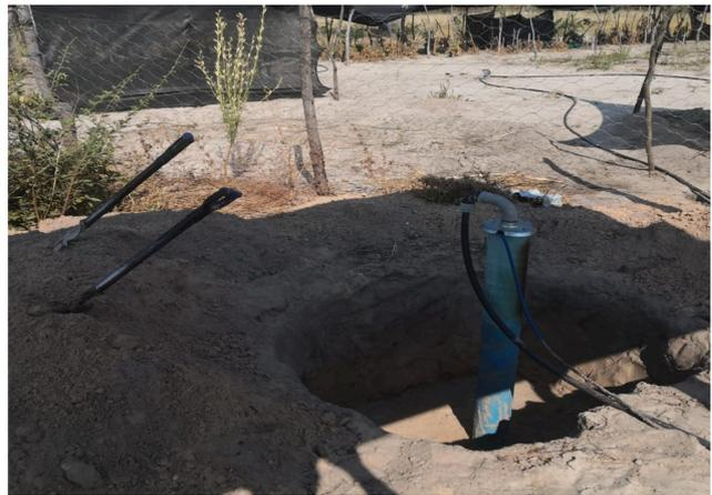
Dieses Jahr häuften sich die Meldungen über Diebstähle von Solarpumpen für die Wassergewinnung im ganzen Land. Als sich die Meldungen unserer Region näherten und Wasserpumpen entwendet wurden, beschlossen wir, die Pumpe mit einem Schloss zu sichern. Die Arbeiter stellten ein Gestell her, betonierten es ein und sicherten es mit einem Vorhängeschloss, so dass es unmöglich ist, die Pumpe auszubauen und zu entwenden.
